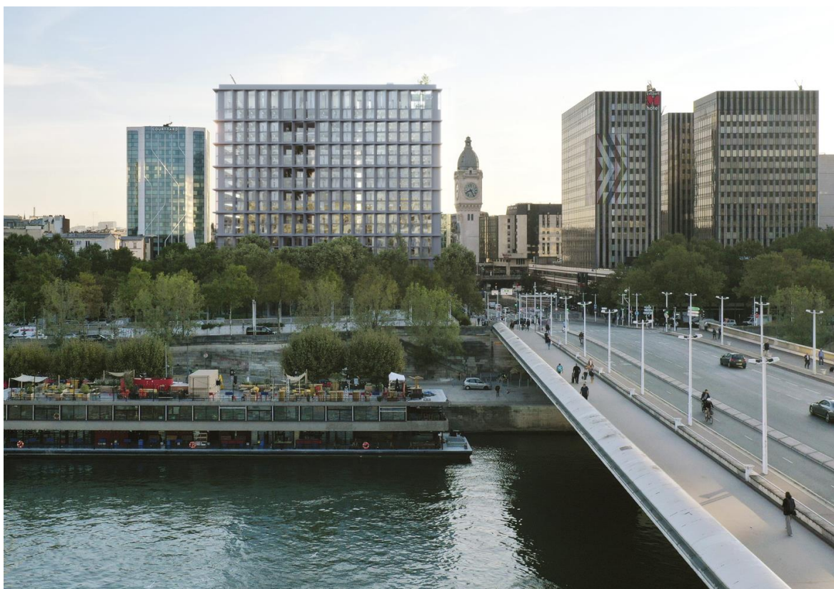
Scope - 68-74 quai de la Rapée (Paris 12 e )
