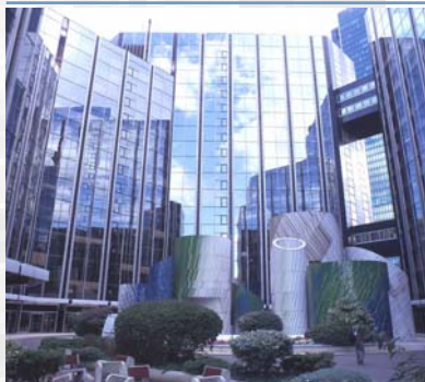
Tour Miroir – Building C La Défense
